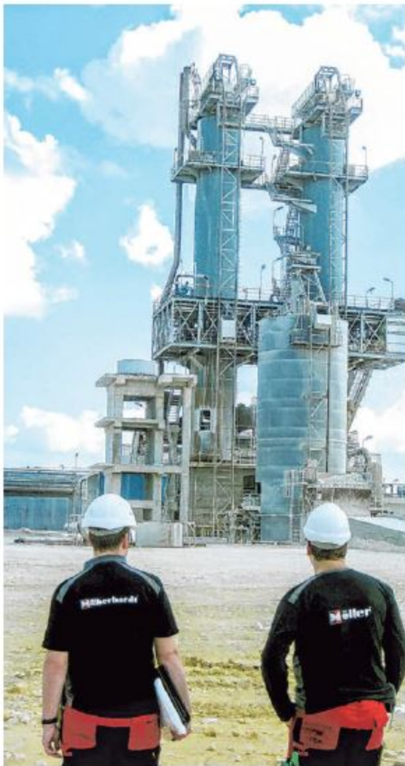
Technik aus Lemgo: Am Nil stehen diverse Zementfabriken mit Öfen der M-Group. FOTO: MÖLLER
